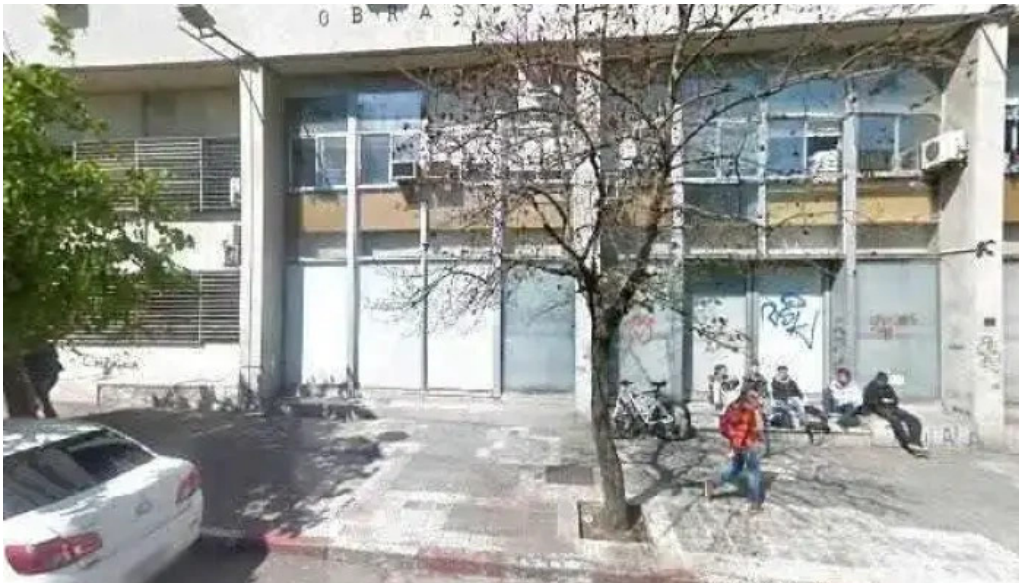
Cerrajería del cordon montevideo
