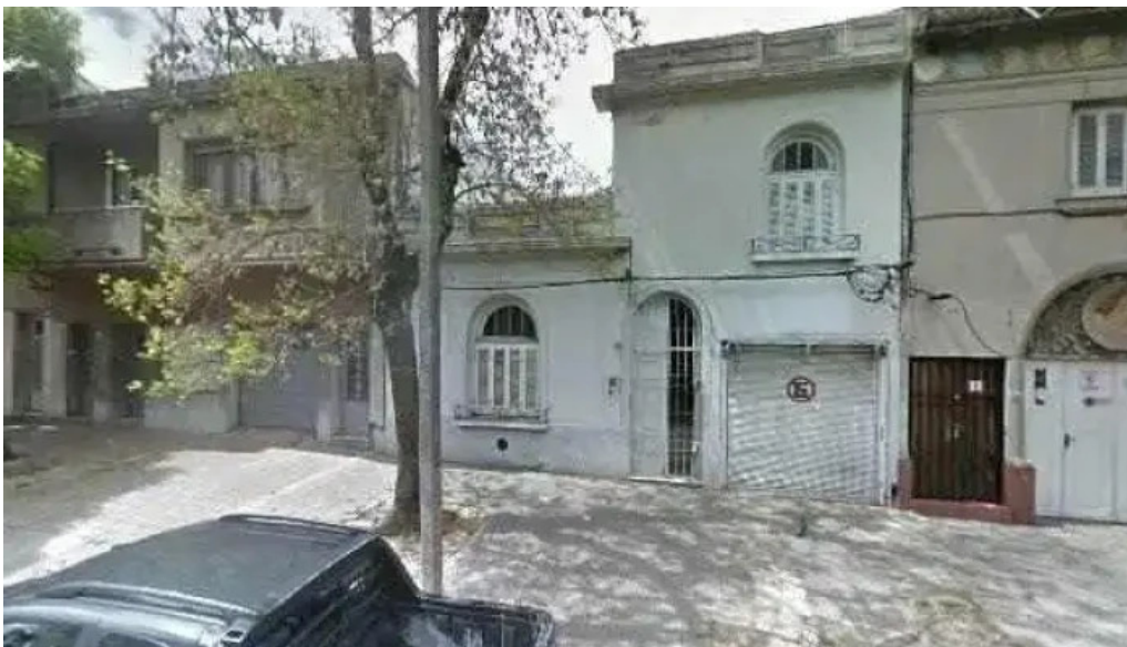
Puertas blindex reparacion 24 horas y venta montevideo
