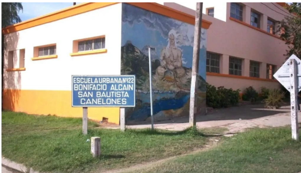
Escuela ndeg 122 bonifacio alcain edificio
