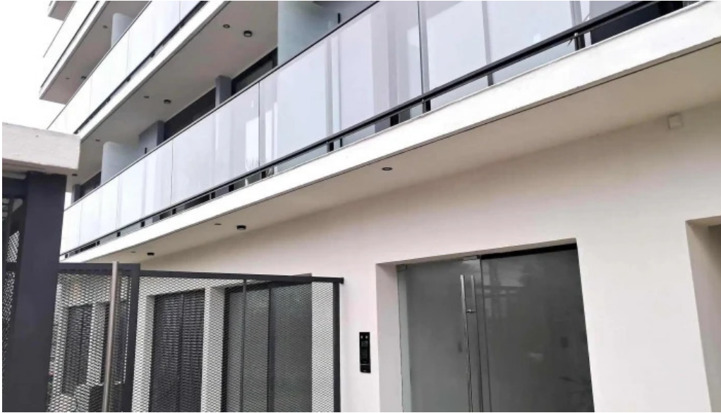
Gandolfo electricidad exterior
