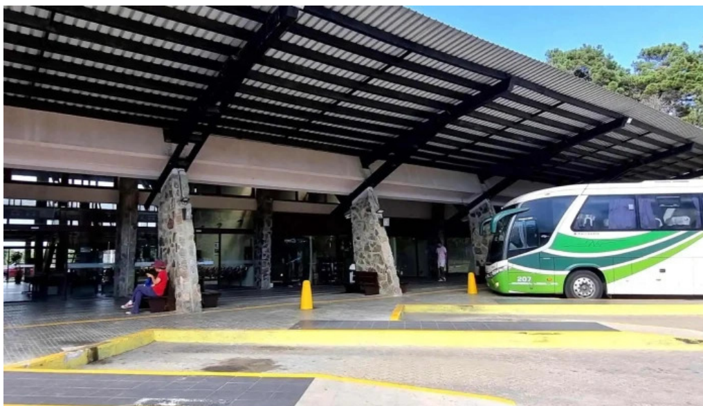
Terminal de omnibus de la paloma ubicacion
