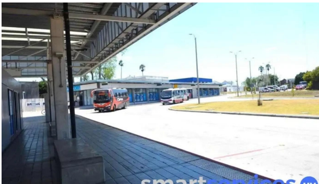
Terminal multimodal de colon direccion
